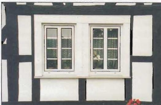
Das querliegende Einscheibenfenster widerspricht der Fachwerkkonstruktion. Das gesamte Feld, in dem das unproportionierte Fenster sitzt, wurde herausgetrennt, das Ständerwerk verdorben. Ein solches Fenster müßte Hausverbot erhalten. Es paßt nirgends und zerstört am gründlichsten.
