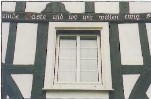
Gut gemeint, aber mißlungen ist der Fenstereinbau auf dem dritten Foto: Wer genau hinschaut, erkennt die überbreiten Kunststoffrahmen, die Gummiabdichtungen rings um die Scheiben, die Alu-Fensterbank, die bedauerliche Überdeckung des schwarzen Mittelpfostens, der zur Konstruktion des Hauses gehört... Für das schöne Bauernhaus, das so „renoviert“ wurde, eine Schande.
