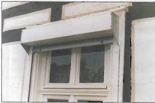
Das schöne alte Fachwerk auf dem zweiten Bild verdient nicht ein solches Fenster: Dem Rahmen fehlt jede Profilstruktur, statt einer ordentlich gebauten Fensterbank (wie unten rechts im Bild) wurde hier nur ein Blech angeschraubt; das Fenster ist einflügelig und hat unechte Sprossen zwischen den Gläsern; die Kippstellung läßt das Haus fortwährend blinzeln.
