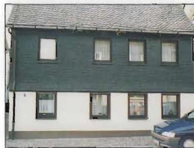
Wie die Abstufung eines Hauses einsetzt, kann man oben rechts sehen: Im Obergeschoß sind neue Fenster eingebaut worden: „Einscheibendrekkippflügel“ an Stelle der komfortablen vierflügeligen Fenster, wie sie das Erdgeschoß noch schmücken. Zwar hat man sich Mühe gegeben, die alten Rahmen nachzubauen, aber die unechten Sprossen können den Charme eines originalen Fensters nicht ersetzen. Wenn das Erdgeschoß ebenso renoviert wird, verliert das Haus endgültig seinen Reiz.
